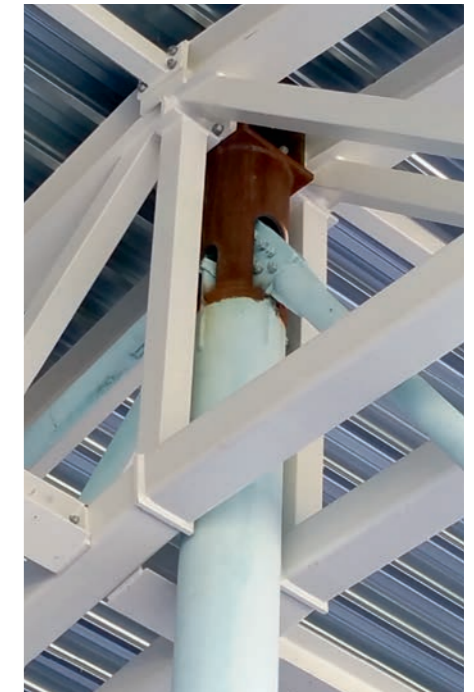
Nieuw kroonstuk is geplaatst.
