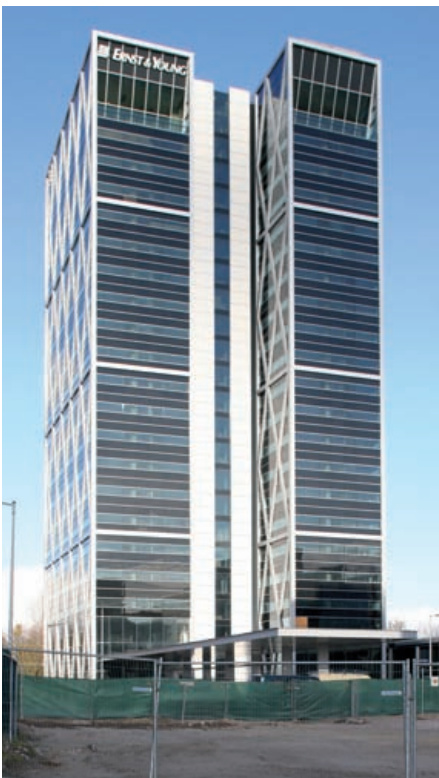
Aanzicht zuidgevel met de diagrid zichtbaar in de westgevel. Het achteraf aanpassen van de gevels veranderde de stabiliteitsvoorzieningen compleet.
