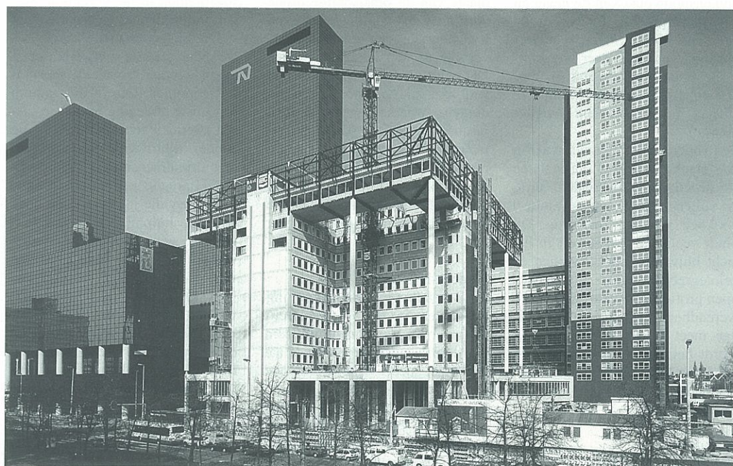
Het bouwterrein van het Unilever-kantoor ligt aan het Weena in Rotterdam, tussen de hoogbouw van Nationale Nederlanden (links) en de Weena-toren (rechts). Een complicerende factor was het gegeven dat de noord-zuid metrolijn ondergronds de locatie doorsnijdt.
