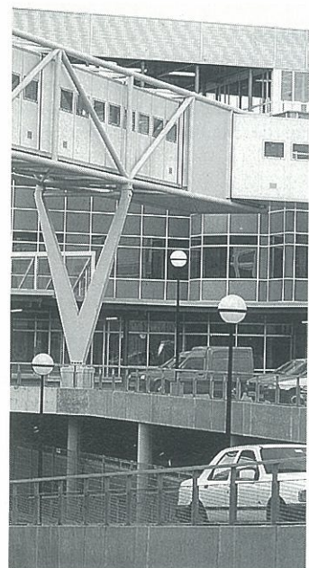
Scharnierende aansluiting van de verbindingsbrug tussen de tuibrug en het Sophia Kinderziekenhuis. De verbindingsbrug lijkt door de tuibrug heen te steken; een effect dat wordt versterkt, doordat de draagconstructie van de verbindingsbrug aan de buitenzijde niet zichtbaar is.
