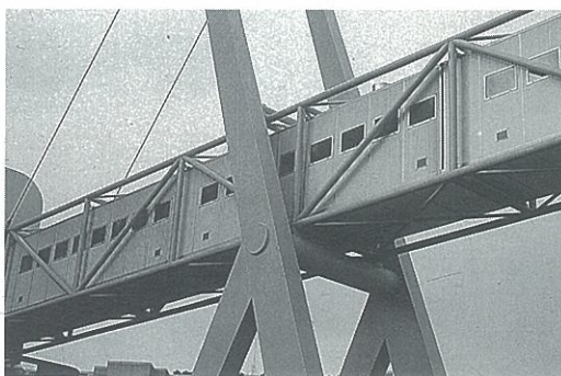
De brug wordt ter plaatse van de pyloon horizontaal gefixeerd door een ronde doek. Om deze kracht op te nemen is de pyloon geschoord.
