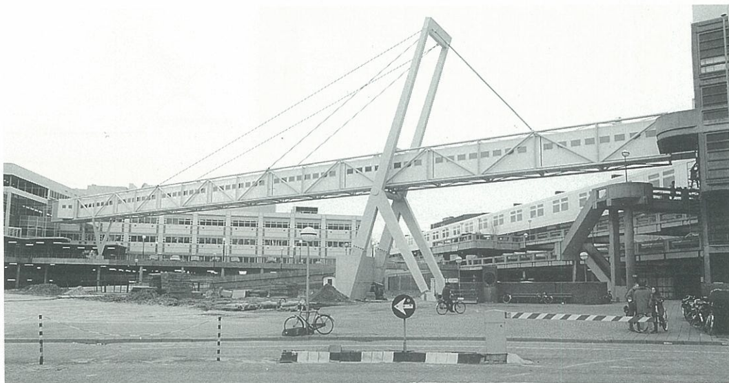
Een getuide brug verbindt het Sophia Kinderziekenhuis (links) met het entreegebouw van de Medische Faculteit (rechts). Het verkeer tussen beide ziekenhuizen moet nu nog door de Medische Faculteit heen.
