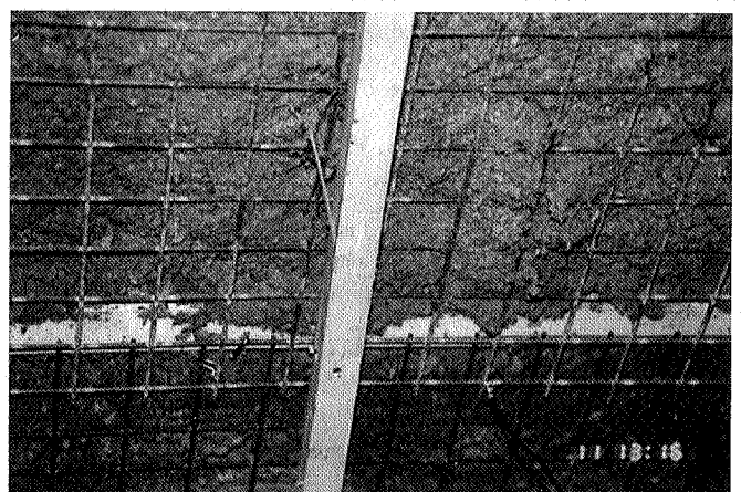
8 Eerste gellaag, externe geleider en aansluiting pluspool hieraan
