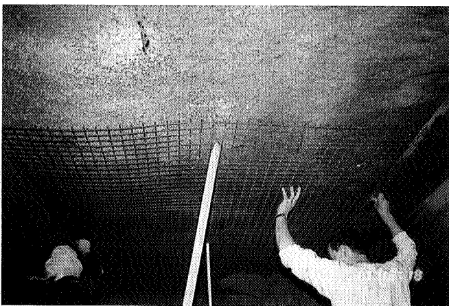
7 Aanbrengen externe geleider, nadat de eerste gellaag is gespoten
