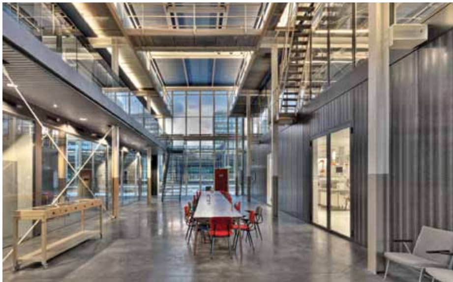
Nieuwe situatie, de laboratoria-opstellingen staan – trillingsvrij – op de funderingen van de oude ketels.
