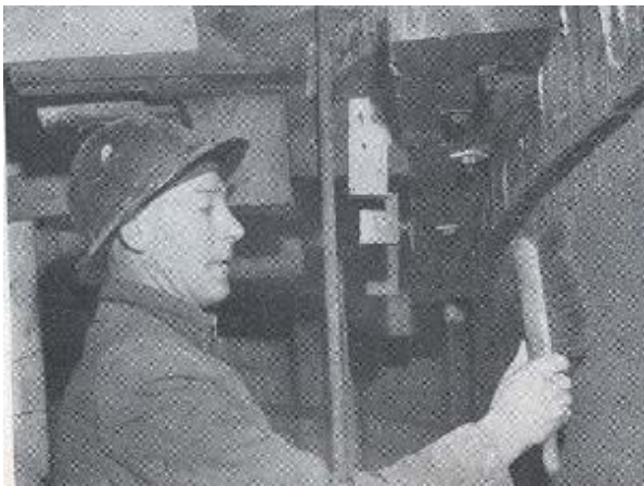
foto 19. afwerken met een stoffer, Euromast, Rotterdam (foto: Openb. Werken R'dam)
