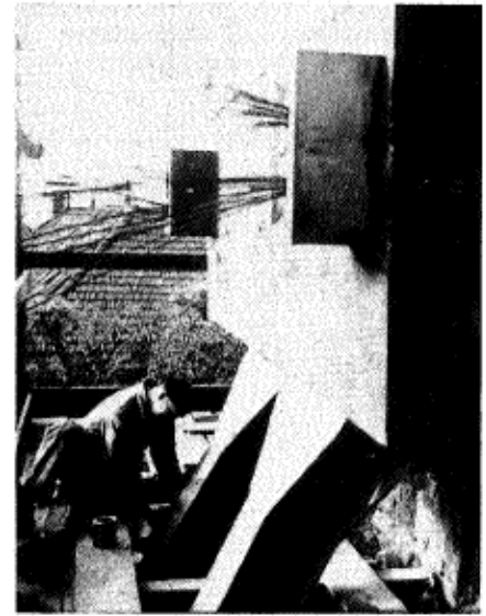
30-31 Een hulpconstructie t.b.v. vernieuwing van de fundering An auxiliary structure for renewing the foundation of the tower
