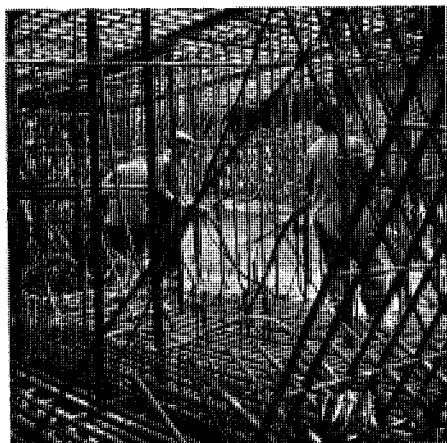
19 Wapening voor de 2-3 m dikke funderingsplaat
