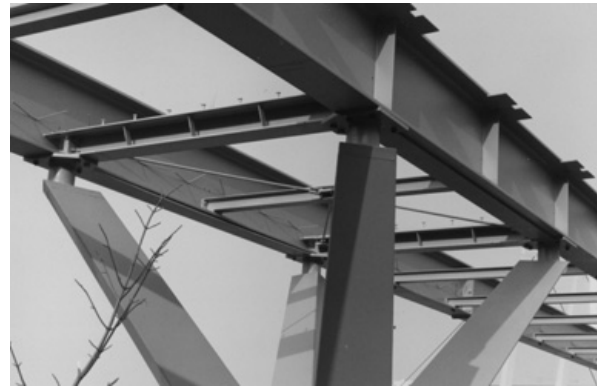
Aansluiting van het brugdek op de pyloon.
