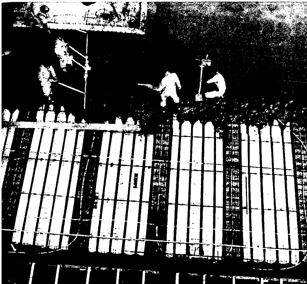
Stortfase van een gedeelte vloer
