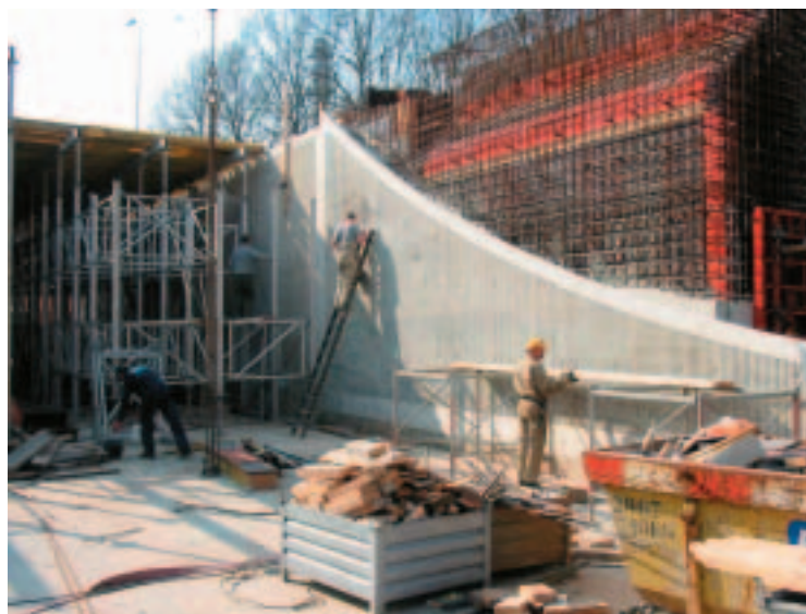
5 | Cannelures in de wanden van de tunnelbak
