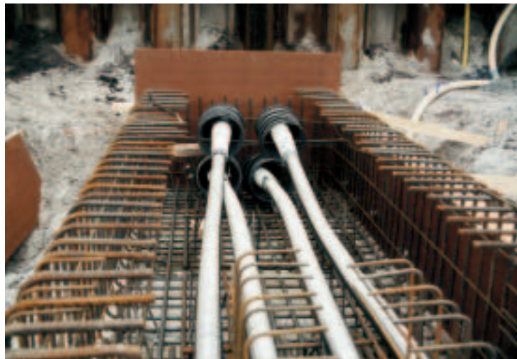
4 | Per kelderbalk zijn vier kabels ingestort
