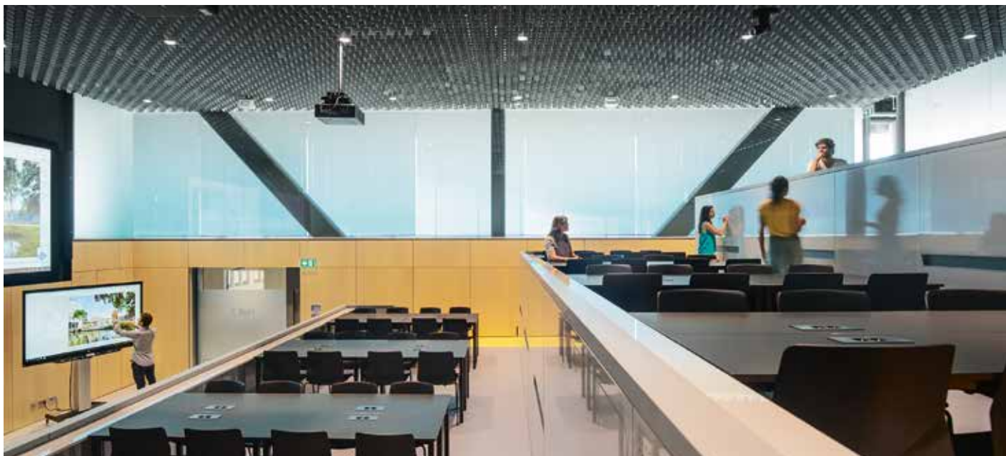
13. Omdat de staalconstructie voor een groot deel in het zicht is geplaatst, is gekozen voor een opschuimende brandwerende coating.
