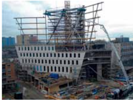
Atriumbuis en gevel werken constructief samen.
