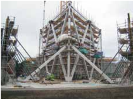
De atriumconstructie heeft twee extra schoren.
