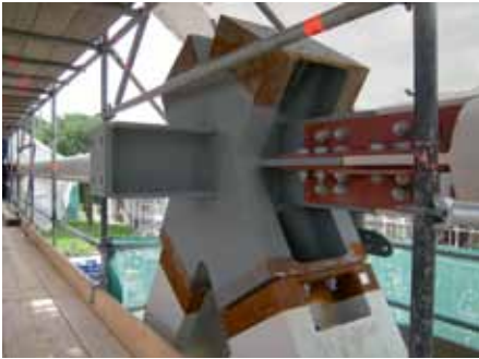
De gietsknoop is integraal onderdeel van de diagonalen.
