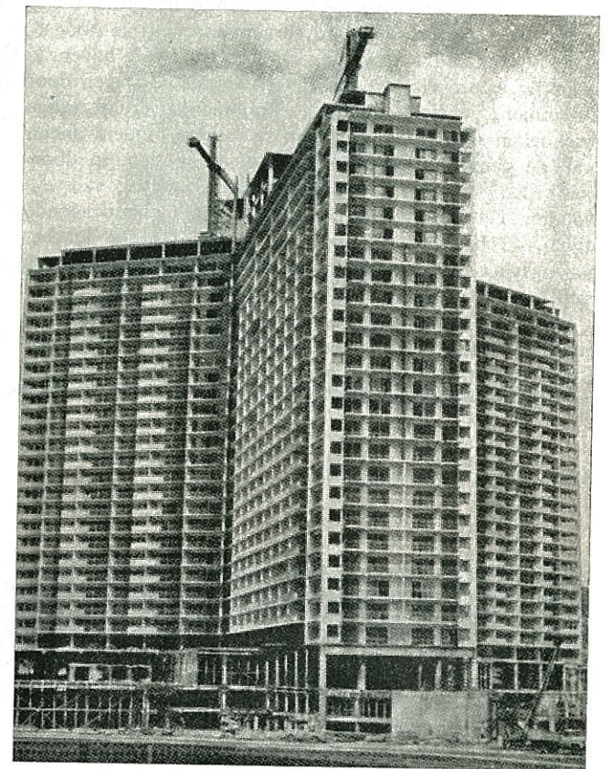
Fig. 1. Duizenden voorspanbetondelen vormen samen de structuur van het Ilikaigebouw (Honolulu).
