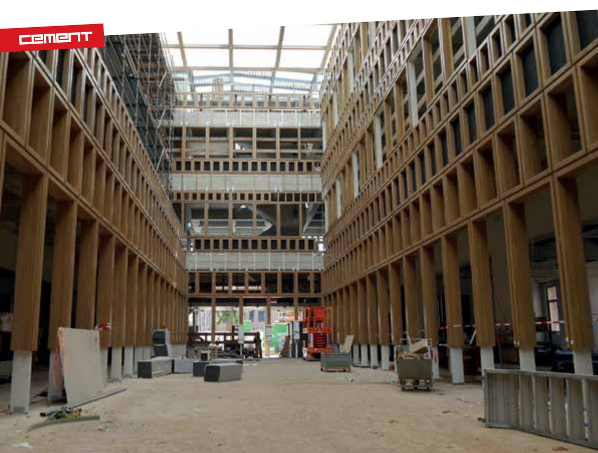
14 Atrium tijdens de bouw 15 Krusing balkwapening bron: BAM Advies & Engineering
